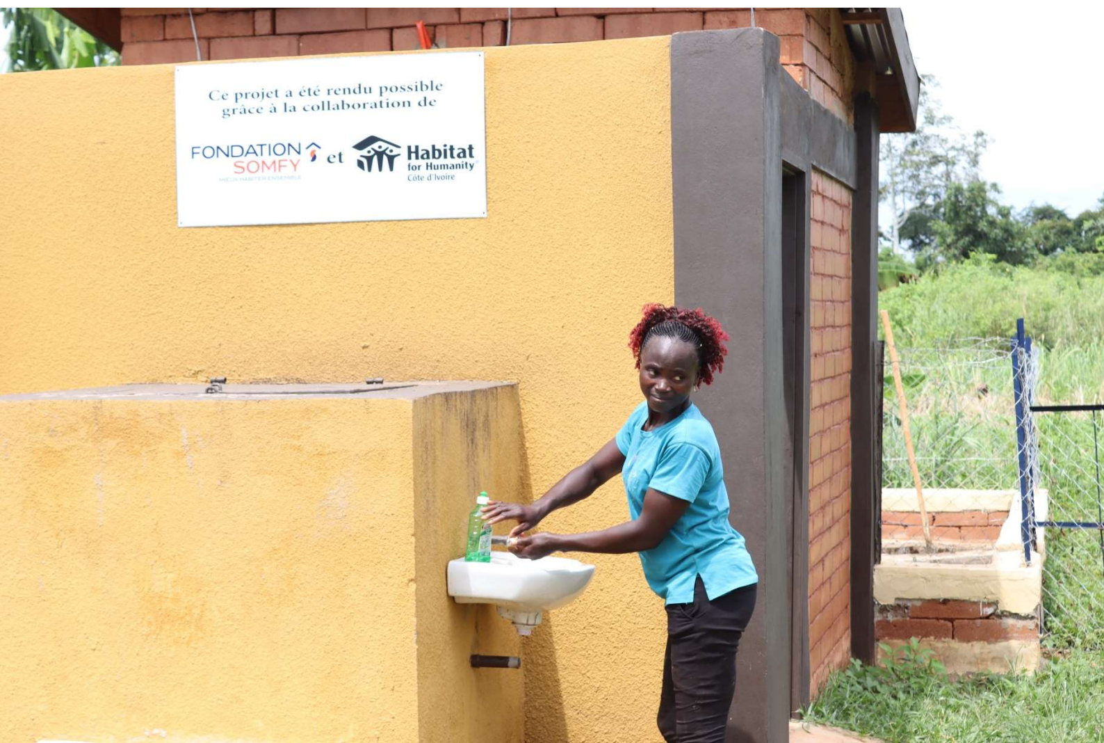
Dida N'Glossou – Toumodi Bloc latrine avec lavage des mains Photo faite par le Service RD&C
