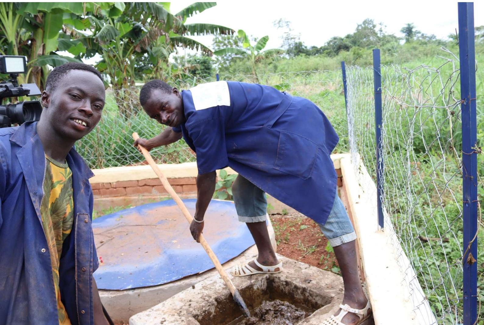
Dida N'Glossou – Toumodi Bloc latrine avec système biogaz Photo faite par le Service RD&C
