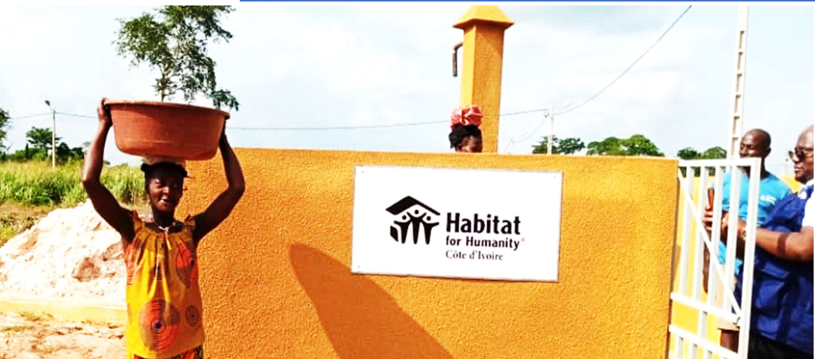
Dida N'Glossou – Toumodi Pompe solaire avec borne fontaine Photo faite par le Service RD&C
