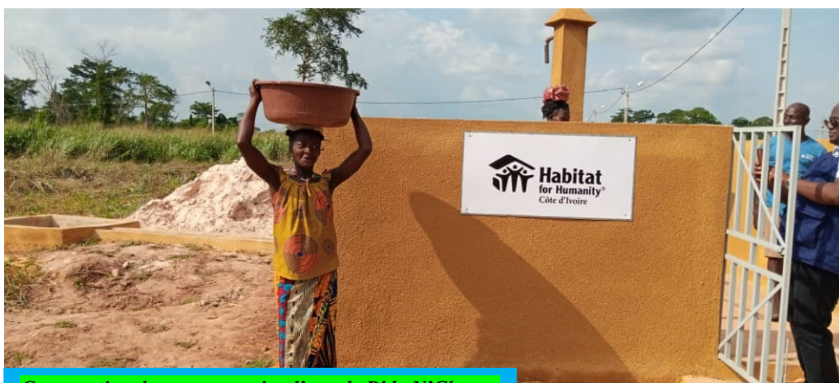
Construction du nouveau point d’eau de Dida N’Glossou
