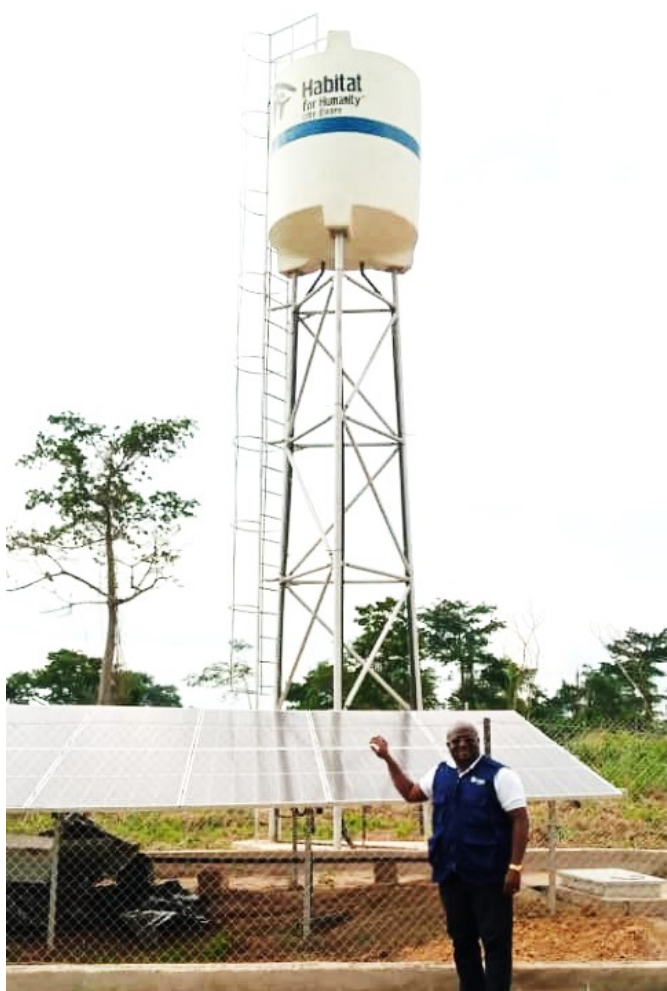
Retenue d’eau installée et alimentée grâce à l’énergie solaire
